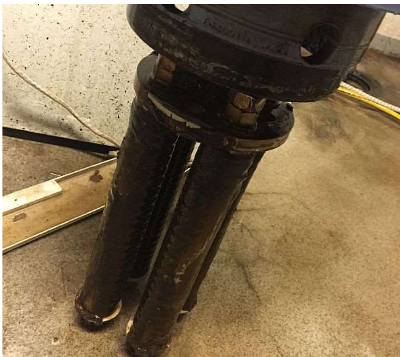
Magnetstavar i filtret fångade upp magnetiska partiklar
